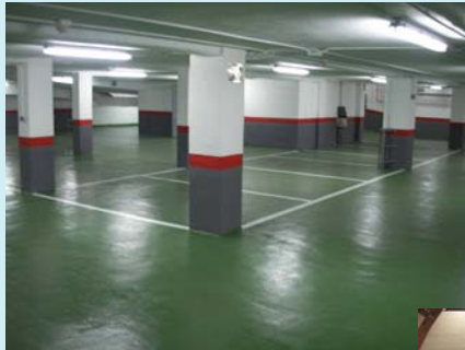
Rehabilitación de parking. Fresado intenso para eliminar antiguo slurry, mortero seco epoxi ELITE de 5 mm espesor aplicado a llana y helicóptero. Señalización de plazas de aparcamiento.
