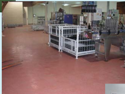
Obrador de pescados. Rehabilitación de suelos con mortero seco epoxi ELITE de 4-5 mm de espesor aplicado a llana y helicóptero.
