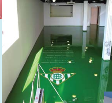
Conservatorio Música. Pavimento Confort mediante sistema con autonivelante de poliuretano elástico con manta de caucho, Amortiguador de ruidos.
