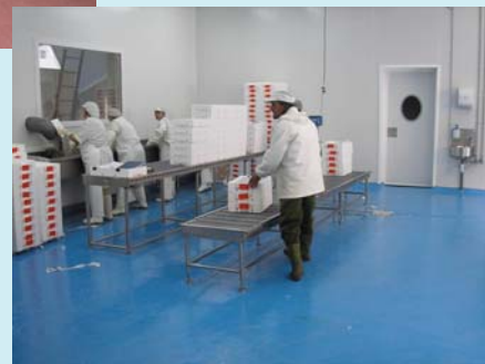
Obrador de pescados. Rehabilitación de suelos con mortero seco epoxi ELITE de 4-5 mm de espesor aplicado a llana y helicóptero.
